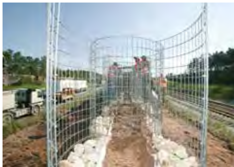
Wenige Bauteile - große Wirkung: Lärmschutzwand an der ICE Strecke Nürnberg-Ingolstadt
