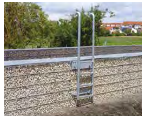
Problemlose Montage von Übersteighilfen und Pralleitern - begehbare Oberflächen (trittsicher)
