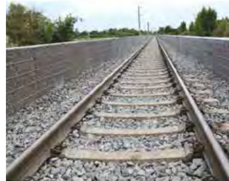
Flachgründung auf vorhandenem Gleisschotter - Sonderlösung mit Kleintierdurchlass
