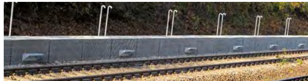
Flachgründung auf vorhandenem Gleisschotter - Sonderlösung mit Kleintierdurchlass
