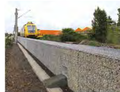
Flachgründung auf vorhandenem Gleisschotter - Sonderlösung mit Kleintierdurchlass
