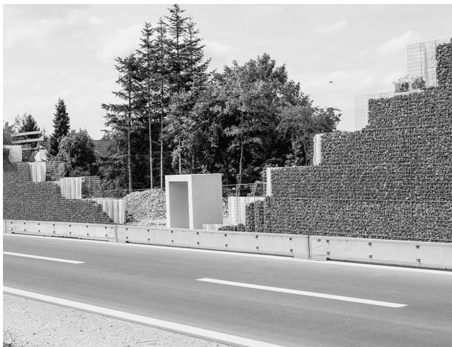
Die freistehende Lärmschutzwand mit Durchgangstür entlang der Abfahrt Moorenbrunn.
