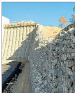
Gabionen: Eine eher unattraktive Aktionsfläche für Graffiti-Sprayer.
